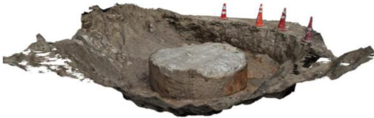
Columna de hormigón
