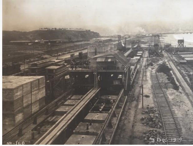
Fabricación bloques de hormigón
