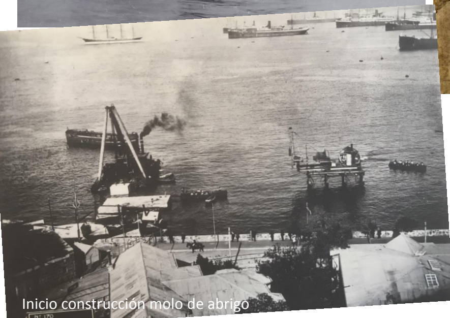
Rellenando de concreto a un cajón monolítico
