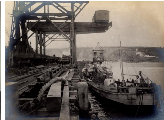
Cargando un Ganguil con enrocados en el Muelle de las Salinas
