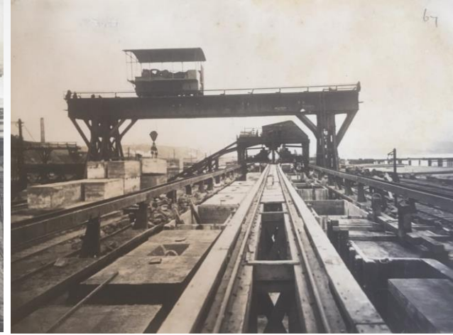
Cancha para la fabricación de bloques de concreto y grúa Goliat de 60 toneladas
